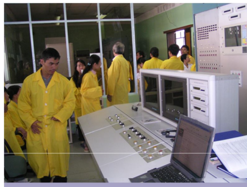
Tìm hiểu thực tế vận hành hệ Điều khiển LPU'
